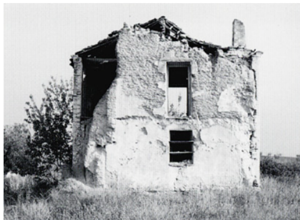
70. Tortoreto, loc. Pizzotondo: casa di terra a schema rettangolare con venne in un secondo momento della sua esistenza anch'essa intonacata e in parte rivestita con murature laterizie.
