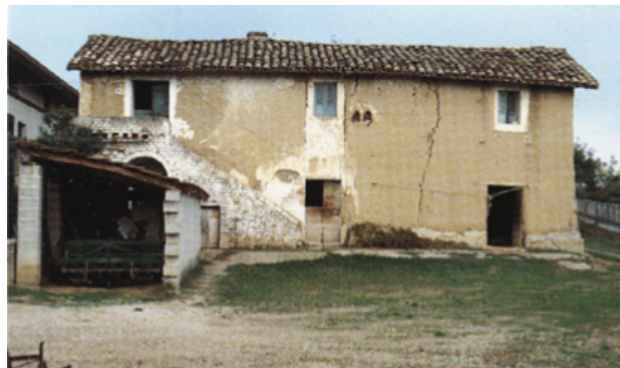
64. Tortoreto, loc. Terrabianca: casa di terra a schema rettangolare con tre vani allineati e due piani.
