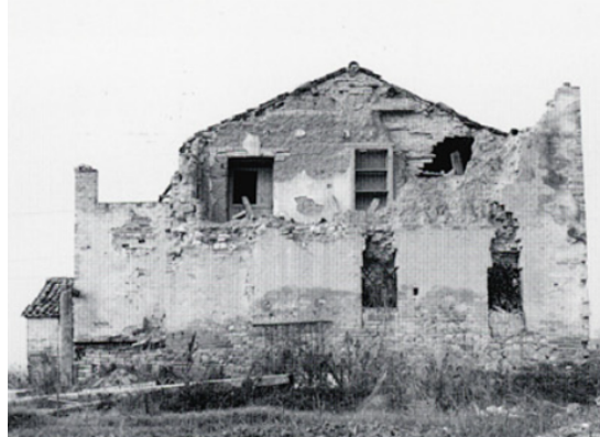
69. Tortoreto, loc. Case San Silvestro: casa in terra a schema quadrato con avancorpo rettangolare e due piani. La struttura venne quasi interamente rivestita in un secondo tempo con murature in laterizio o pietrame e laterizio.
