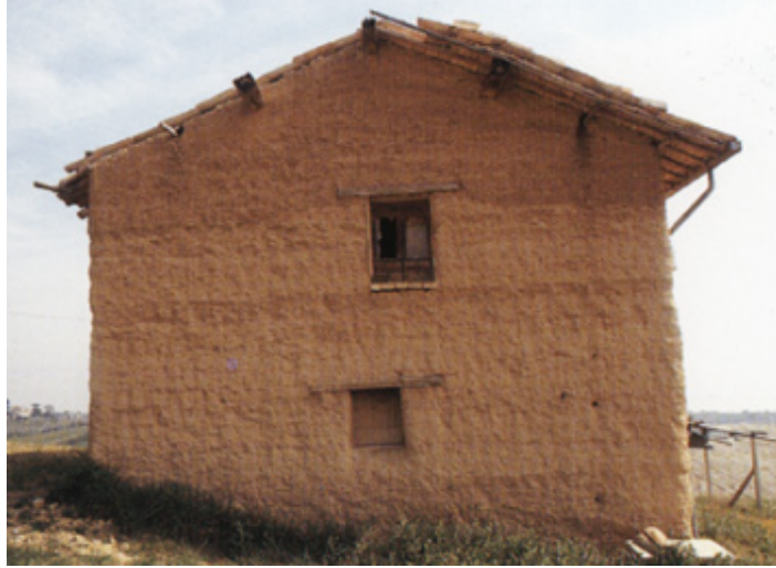
62. Ancarani, loc. Masseria La Volpe: appare ben evidente la tessitura del pise.
