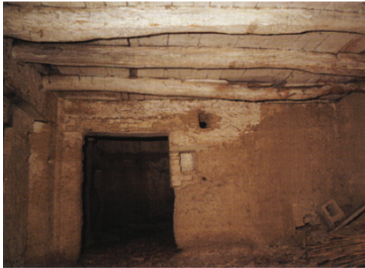
61. Controguerra, loc. La Torretta: casa di terra a due piani. particolare del solaio intermedio.
