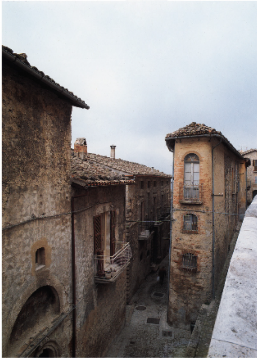
22. Civitella del Tronto. Casa-forte tra via Marconi e via del Forno.
