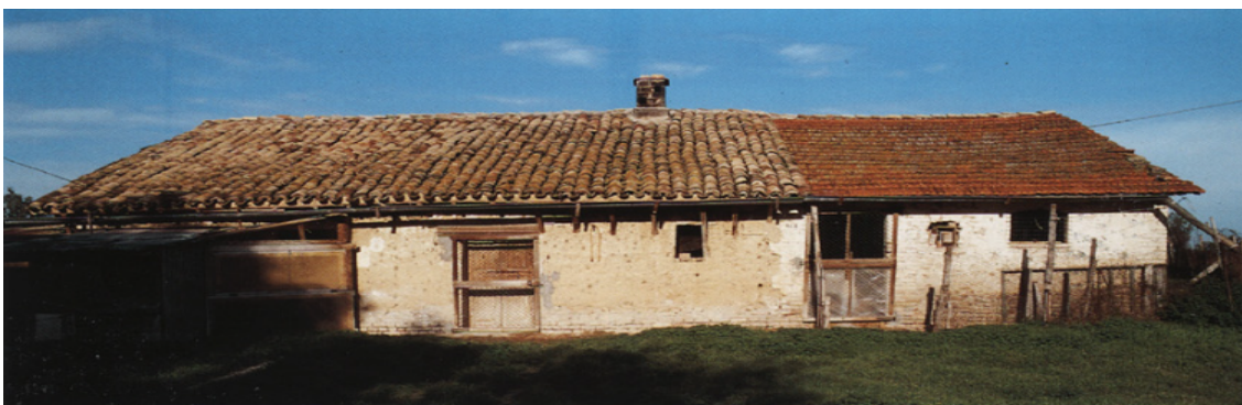
63. Corropoli, loc. Badia: casa di terra a schema tripartito e piano unico. Si noti il parziale rifacimento del vano a sinistra con murature laterizie.
